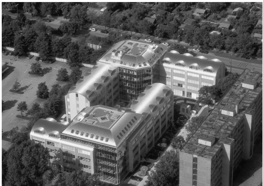
Hervorstechendes architektonisches Merkmal des Bürokomplexes – silbern schimmernde Tonnendächer (Foto: Hoogovens Aluminum Bausysteme GmbH)
